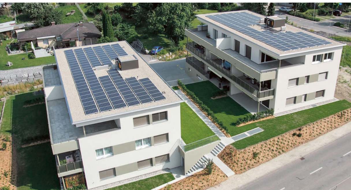
Photovoltaikanlagen auf den Mehrfamilienhäusern Ponyweid.
