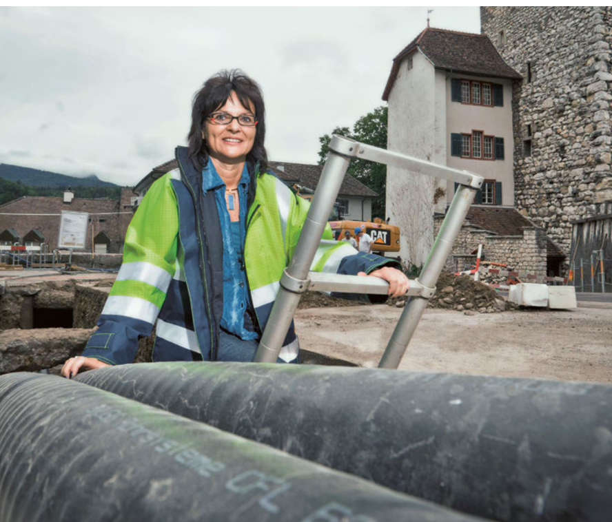
Projektingenieurin Corinna Hunziker überwacht den Bau des Fernenergienetzes: Die Leitungen für Fernwärme und -kälte werden parallel verlegt.
