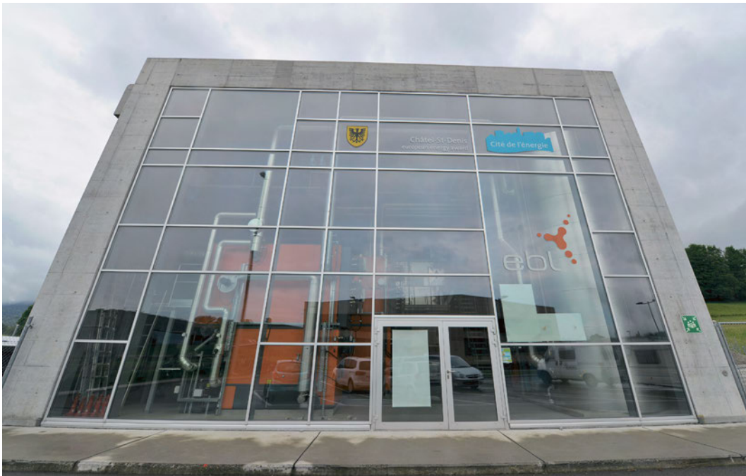
Das Beton- und Glasgebäude lässt den Blick auf die Stahlrohre und die orangen Heizkessel frei.
