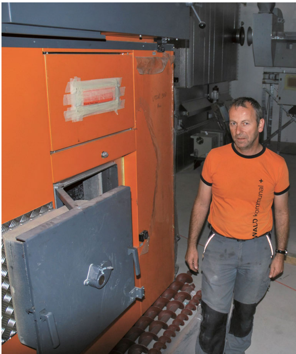
Stefan Staubli, Leiter Wald der Gemeinde Auw: «Stammt die Heizzentrale von einem Schweizer Hersteller, bleiben 95 Prozent der Investitionen im Inland.»
