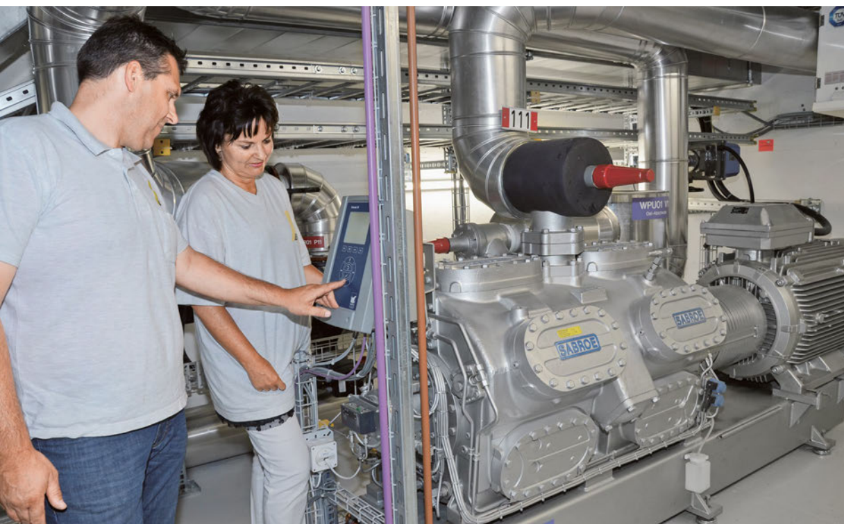
Projektingenieurin Corinna Hunziker und Betriebstechniker Reto Knechtli in der Energiezentrale Kasinopark: Ammoniakwärmepumpen entziehen dem Grundwasser Energie und produzieren damit 75 Grad heisses Warmwasser sowie Kaltwasser fürs Fernenergienetz. Fotos: IBA
