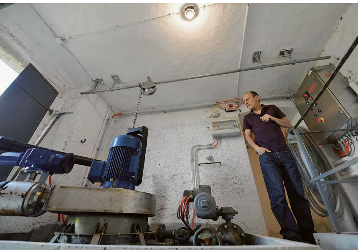
Die blaue Mikroturbine hat eine Leistung von 6,5 kW. Rechts befindet sich der Schaltschrank.
